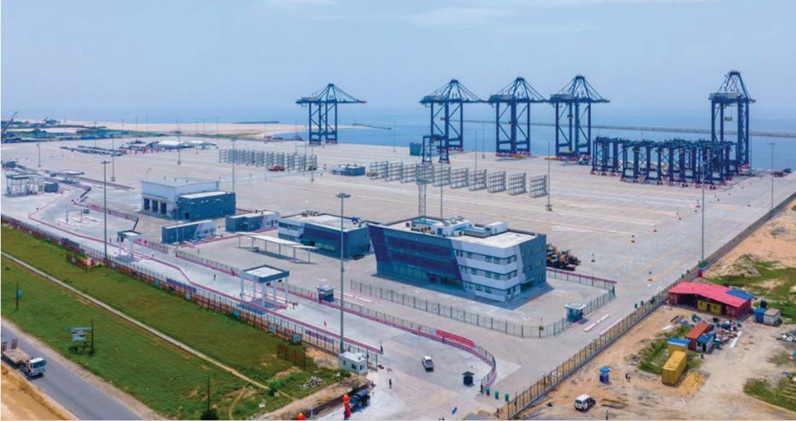
Nijerya'nın Lagos kentinde China Harbour Engineering Company Ltd (CHEC) tarafından inşa edilen Batı Afrika'nın en derin deniz limanı (Fotoğraf: CGTN, 2023).
