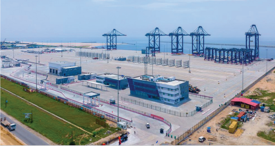
Nijerya'nın Lagos kentinde China Harbour Engineering Company Ltd (CHEC) tarafından inşa edilen Batı Afrika'nın en derin deniz limanı (Fotoğraf: CGTN, 2023).
